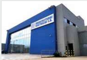
Centro de Distribución LIMA
